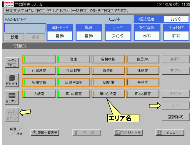
(C) エリア別監視画面 (エリア単位の運転状態を表示)
